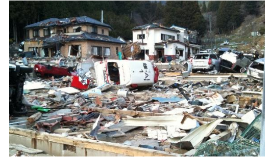
写真提供:(一財)消防防災科学センター 「災害写真データベース」
