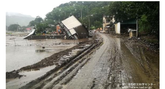
写真提供:(一財)消防防災科学センター 「災害写真データベース」
